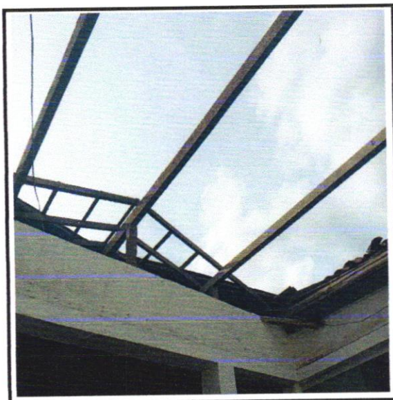
FOTO - 04: DEMOLICAO DE TELHAS CERAMICAS OU DE VIDRO
