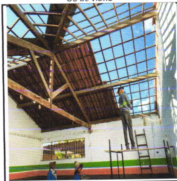
FOTO - 04: DEMOLICAO DE TELHAS CERAMICAS OU DE VIDRO
