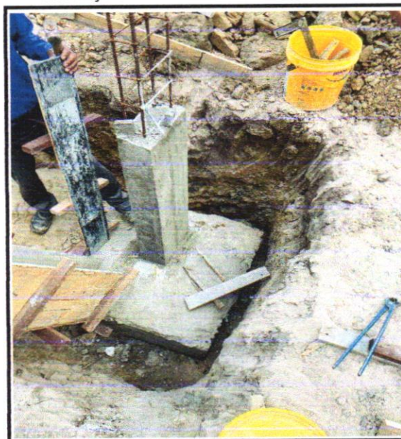
FOTO- 20 COMPOSIÇÃO PARAMÉTRICA PARA EXECUÇÃO DE ESTRUTURAS DE CONCRETO
