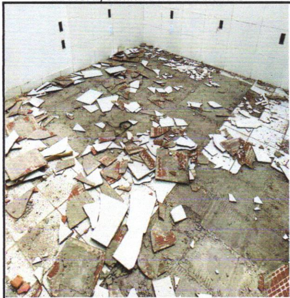
FOTO - 22 DEMOLIÇÃO DE PISO DE FORMA MANUAL, SEM REAPROVEITAMENTO
